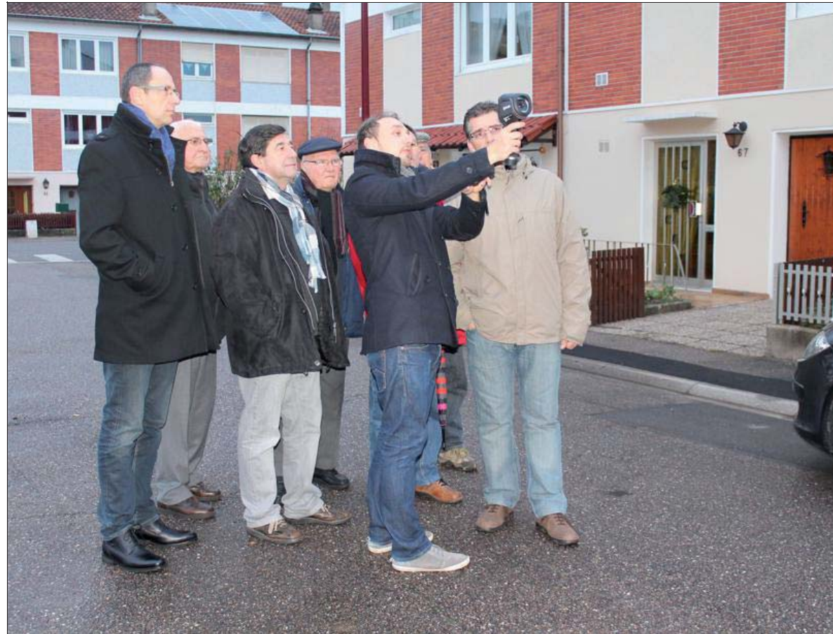
L'auscultation d'une maison permet de découvrir ses éventuelles déperditions de chaleur. Photo RL
